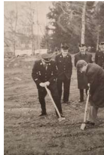
Beim Spatenstich: Kommandant Ortler und Bgm Dr. Riedle
