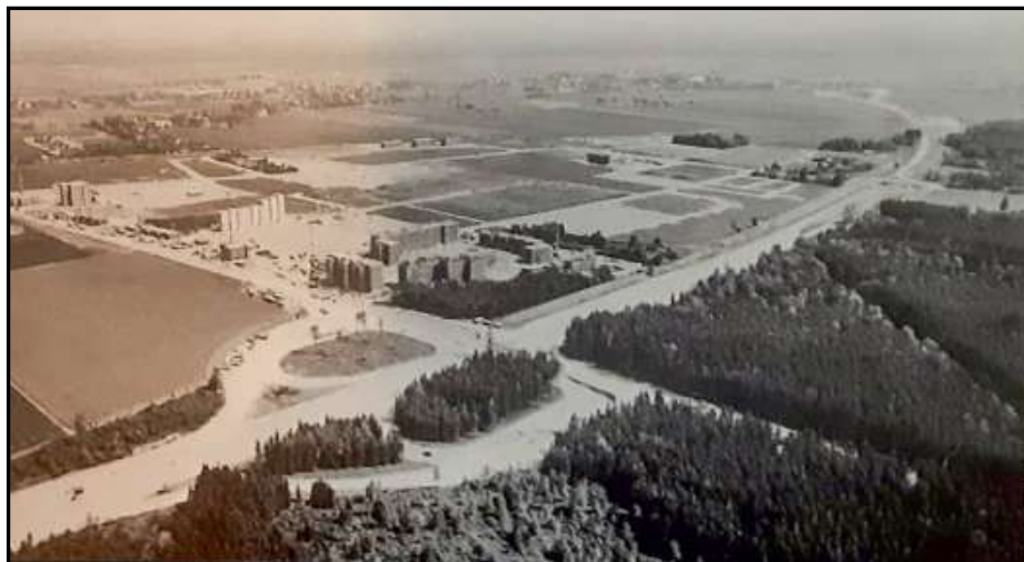
Luftbild der gerade entstehenden neuen Siedlung Am Wald 1970
