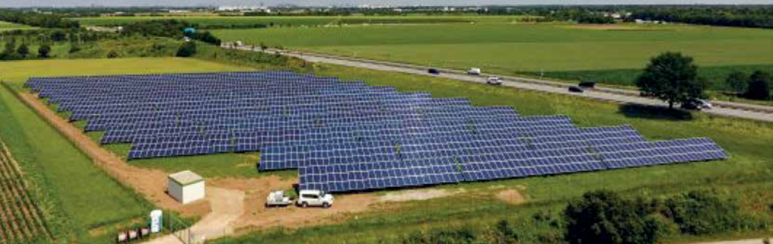
BEU PV-Freiflächenanlage an der A8. Foto: BEU
