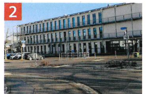
Übergang an der Grundschule Wald / Ahornring
