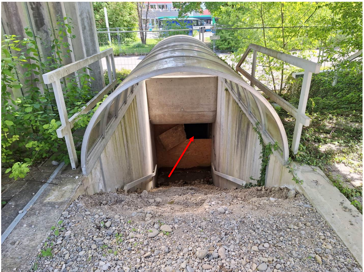
Abbildung 44: Einflugmöglichkeit in eine ehemalige Straßenunterführung im Teilbereich Mitte Ost (Quelle: DRAGOMIR STADTPLANUNG GmbH)
